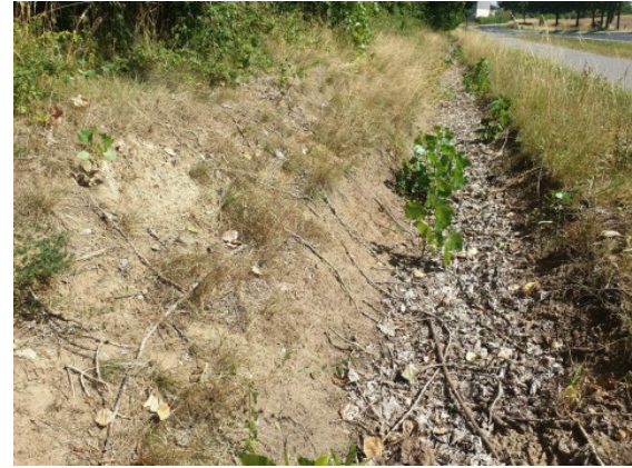
Abb. 16: Südexponierter Grabenabschnitt mit hohem Anteil an freiliegenden Bodenbereichen. Gutow Wald (10.08.2022, Foto: Ingo Brunk).
