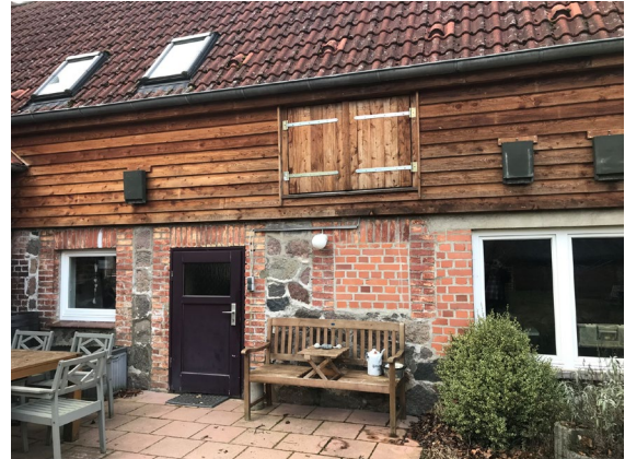
Abb. 1: Ostexponierte Feldstein-/Ziegelwand mit darüberliegender Holzverschalung.
