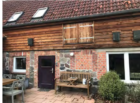
Abb. 1: Ostexponierte Feldstein-/Ziegelwand mit darüberliegender Holzverschalung.
